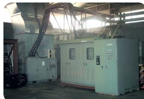
▶ 저항 부하 및 리액티브 부하 설비 (Resistive & Reactive Load Banks)
